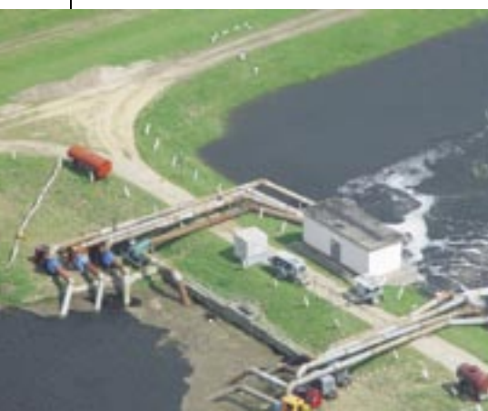
Provisorische Pumpenanlage an der Stelle, wo das Hochwasser auf das Binnenwasser trifft
